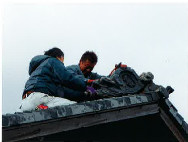
大屋根の名字入の鬼瓦は、いつ崩落しても おかしくない状態! 下見に来てもらった亀井 棟梁と中村互親方がはがしてくれました♡
