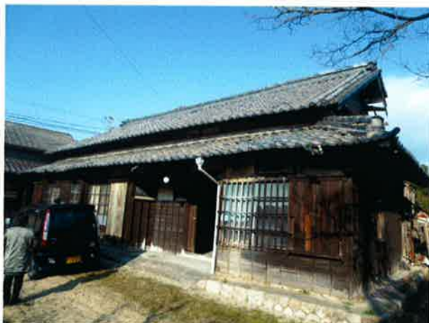
大屋根の名字入の鬼瓦は、いつ崩落しても おかしくない状態! 下見に来てもらった亀井 棟梁と中村互親方がはがしてくれました♡
