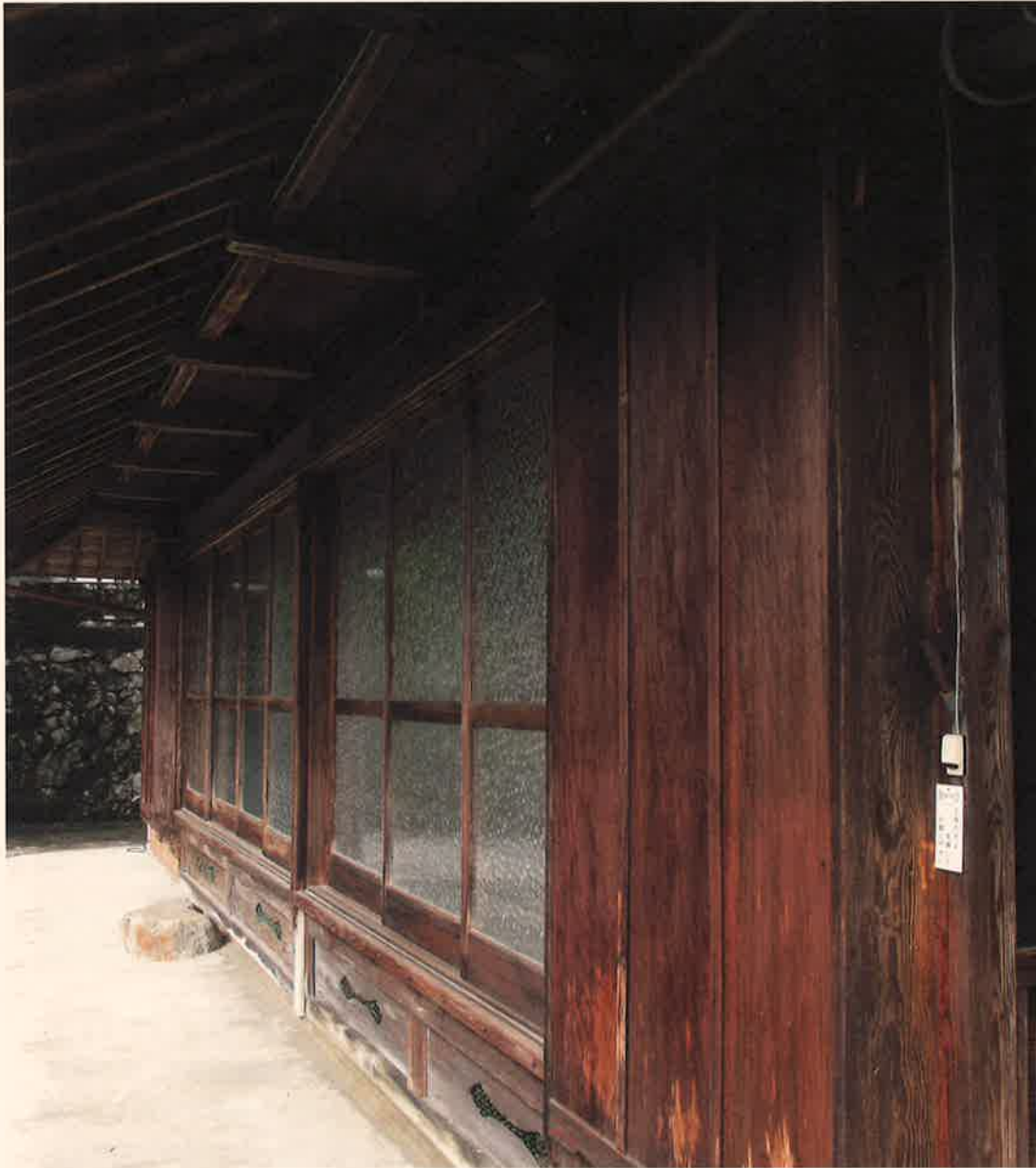
床下換気口から侵入する隙間がないか家周りも一周チェックしましょう
