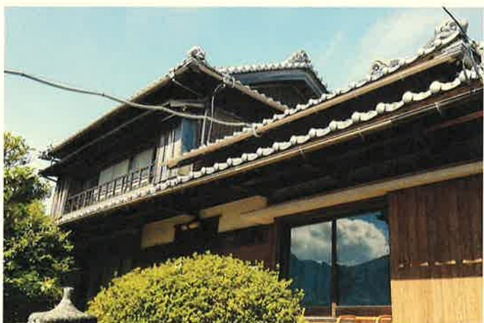
診断を行った古民家。築54年。
