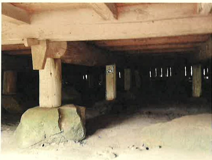
床下写真。腐朽・蟻害などが見られず健全。
