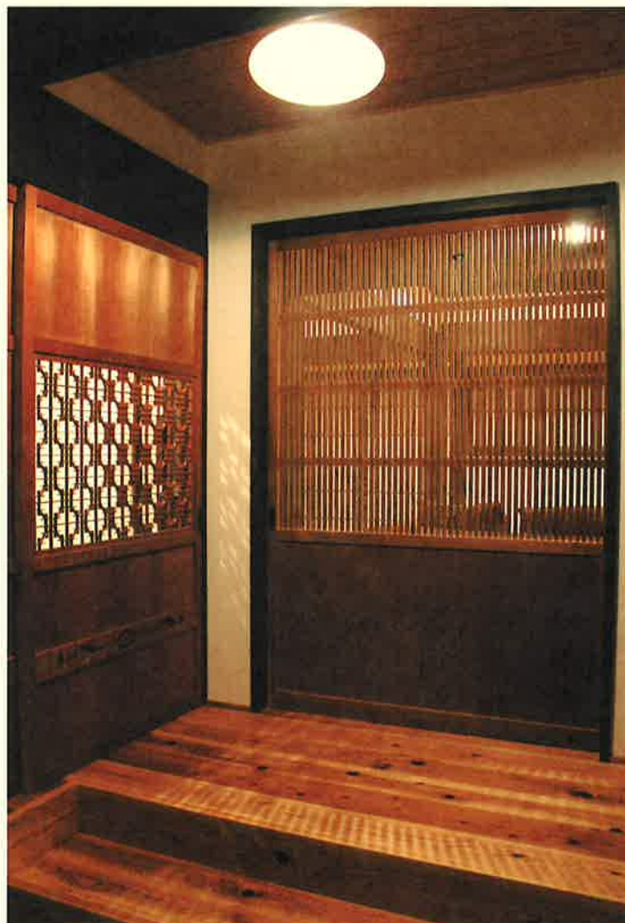
【玄関】格子細工が美しい建具は、三重県内で解体された古民家から譲り受けたもの。框・式台・床・天井すべてに杉の無垢材を使った。
