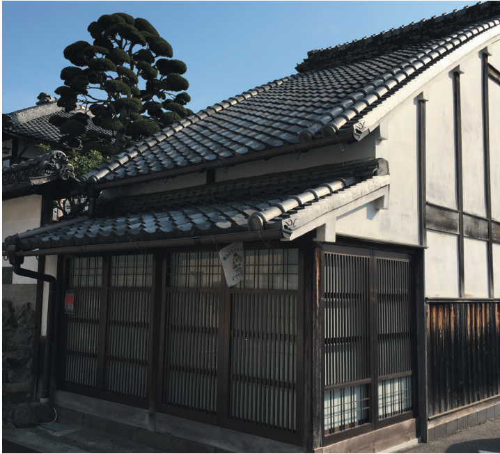
写真① 栄楽館外観。むくり屋根になっている
