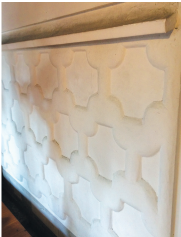
写真③ 蔵の外壁のなまこ壁
