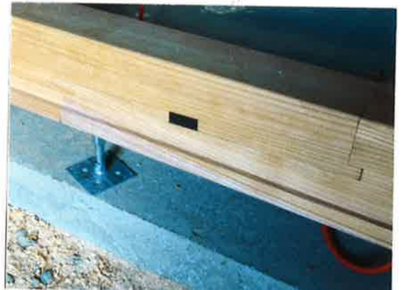
上がり木匠は2本を継いで全長約5.6m。大工さん渾身の継ぎ手は「金輪継ぎ」。中央の柱は黒壇。用強美の形です。
