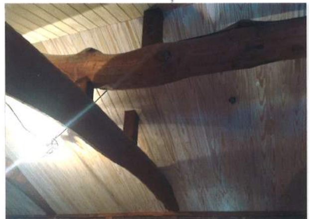
下地の室内側に、杉板張りをしました。
