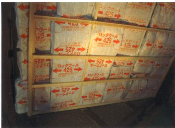
下地を組んで、断熱材を敷いています
