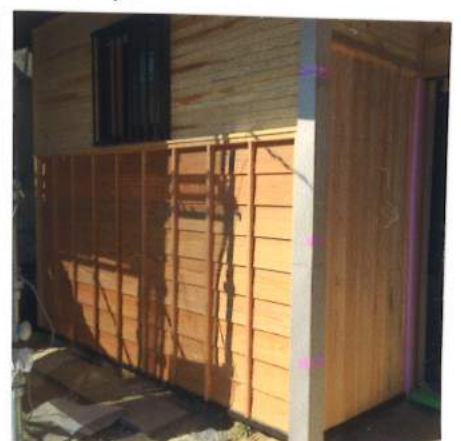
筋子下見板張り部分の完成!
