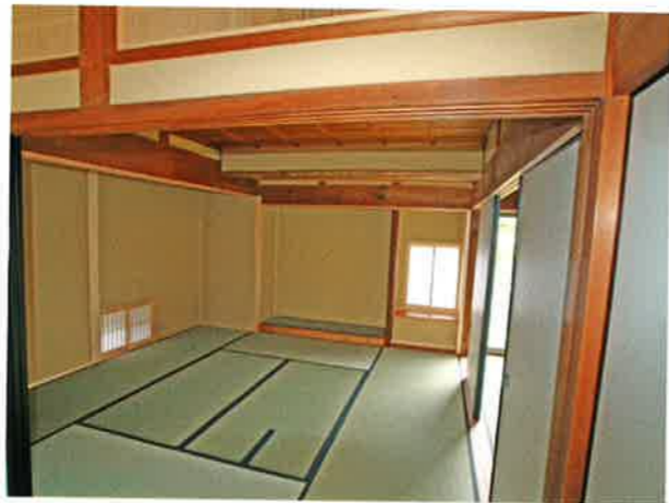
四日市市U様邸 古民家再生工事 2010.4 by TAP
