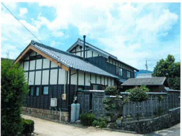
三重郡菟野町 M様邸 古民家再生工事
